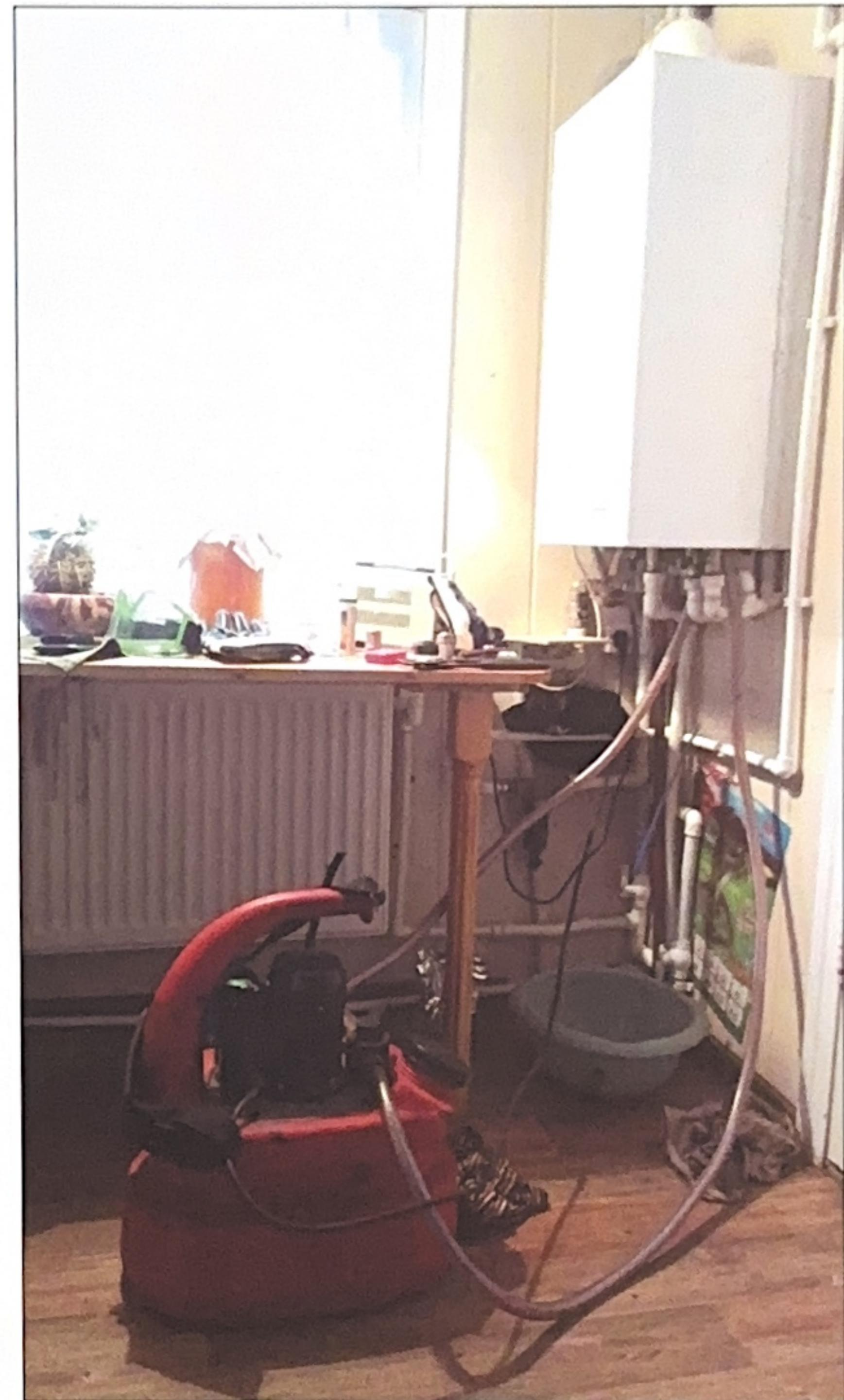
Рис. 4. Установка для промывки бытовых котлов.
