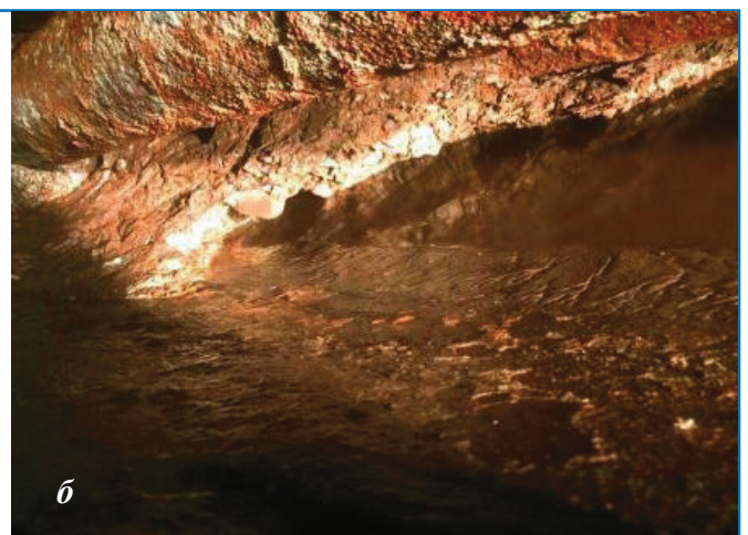
Рисунок 3. Образование накипи: а – в местах приварки дымогарной трубы к трубной доске (красной стрелкой обозначена трубная доска, синей – дымогарная труба, в центре – слой накипи); б – на нижних дымогарных трубах котла.
